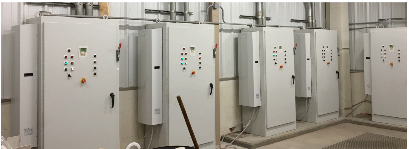
Pfannenberg Luft-/Wasser-Wärmetauscher im Pumpensterraum einer Abwasseraufbereitungsanlage
