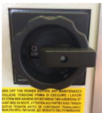
Figura 11 – Sezionatore generale
