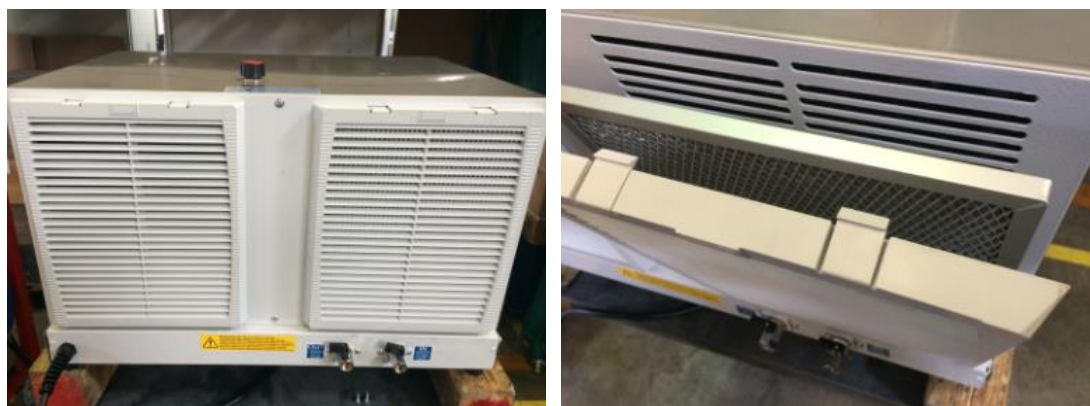
Figura 21/22 – Sostituzione filtro aria
