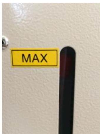
Abbildung 10 – Befüllverfahren und Höchststand
