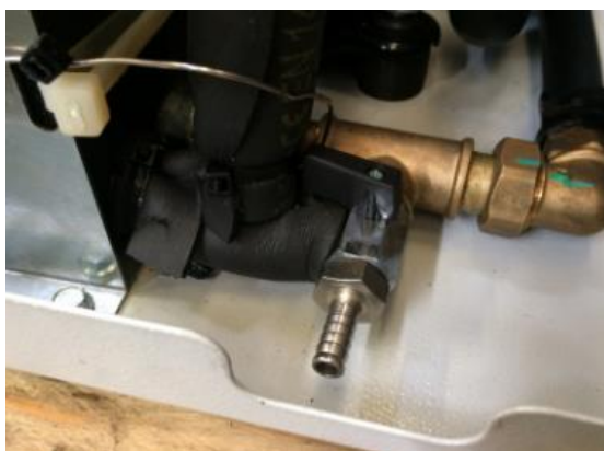
Figura 8 – Connessione idraulica di svuotamento
