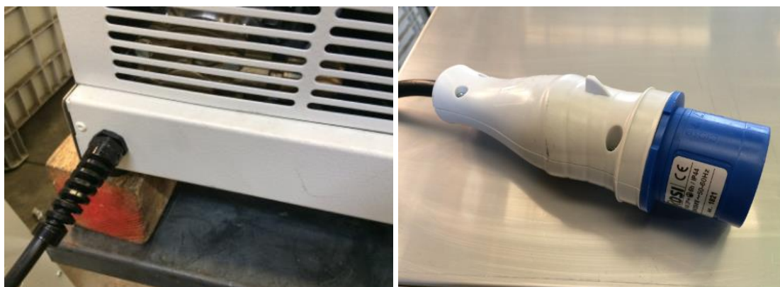
Figura 9/10 – Piastra per i collegamenti elettrici
