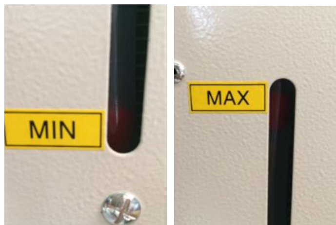
Figura 16 / 17 – Rabbocco del serbatoio
