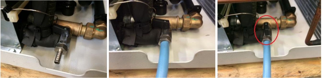
Figura 24 – svuotamento del refrigeratore
