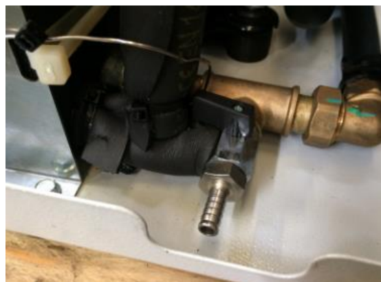
Abbildung 5 - Hydraulische Entleerungsverbindung
