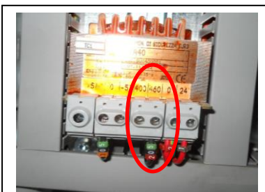
Рисунок 6 Трансформатор с 460В
