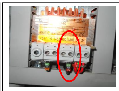
Figura 6 Trasformatore impostato a 460V
