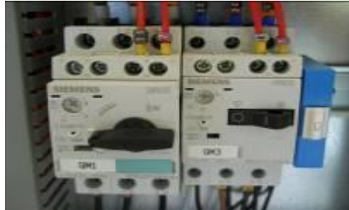
Figura 8 – Interruttori di circuito OFF
