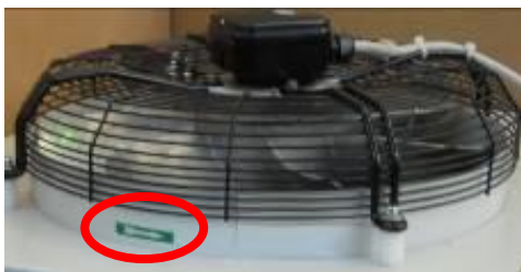
Figure 21 – Sens de rotation du ventilateur
