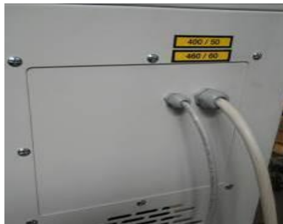
Figura 4 – Piastra per i collegamenti elettrici
