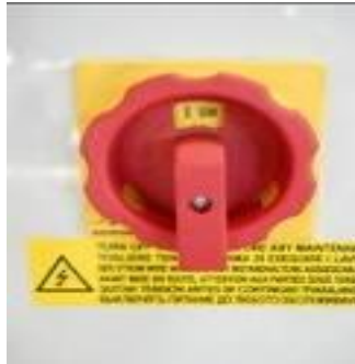
Abbildung 17 – Hauptschalter auf ON
