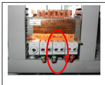
Figure 5 Transformateur réglé sur 400V
