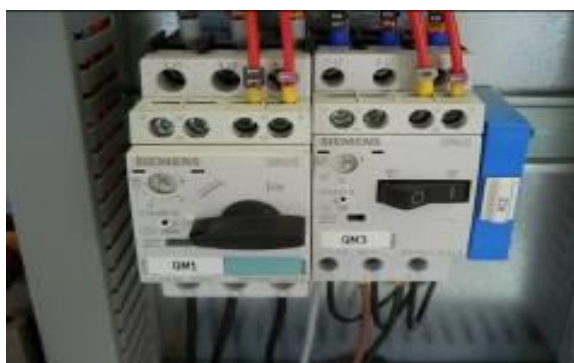
Рис. 16 – выключатель насоса ВКЛ.
