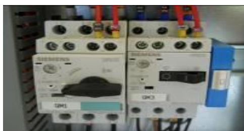
Рис. 8 – Выкл.контура ВЫКЛ.
