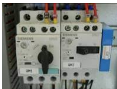
Figure 20 – Tous les interrupteurs de circuit sur ON
