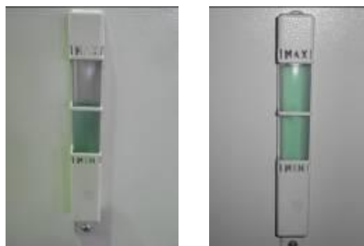
Figura 18 / 19 – Rabbocco del serbatoio
