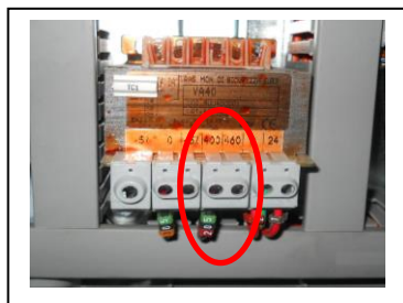
Рисунок 5 Трансформатор с 400В
