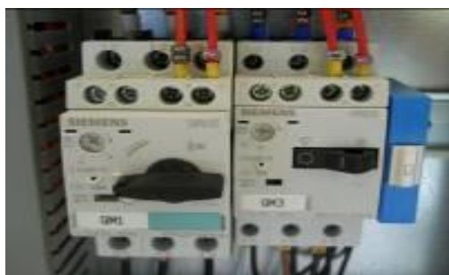
Figure 8 – Interrupteurs de circuit OFF
