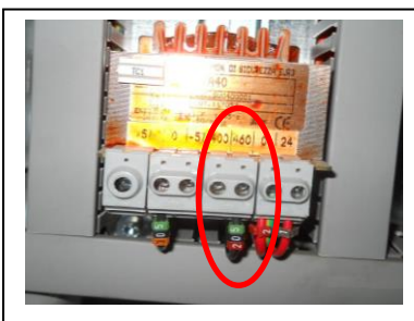
Figure 6 Transformateur réglé sur 460V
