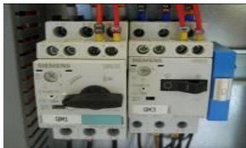
Abbildung 8 – Trennschalter OFF
