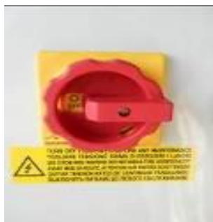
Figure 7 – Interrupteur général OFF
