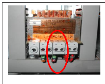
Figura 5 Trasformatore impostato a 400V
