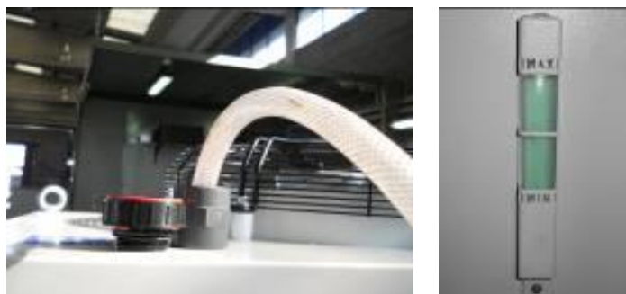
Abbildung 11 / 12 – Befüllverfahren und Höchststand
