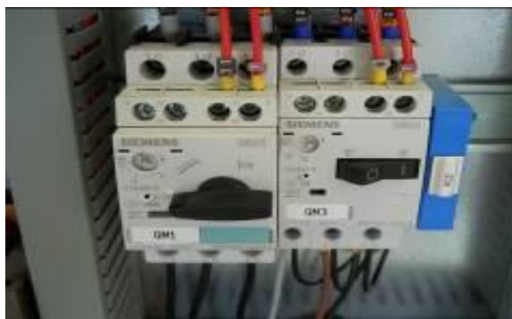
Abbildung 16 – Pumpenschalter auf ON
