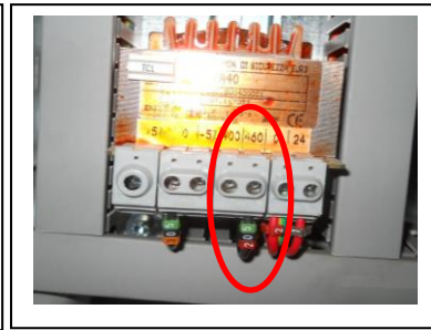
Abbildung 6 Auf 460V eingestellter Transformator
