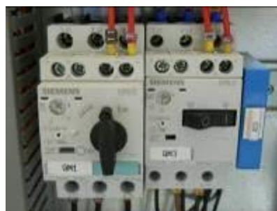
Abbildung 20 – Alle Trennschalter auf ON
