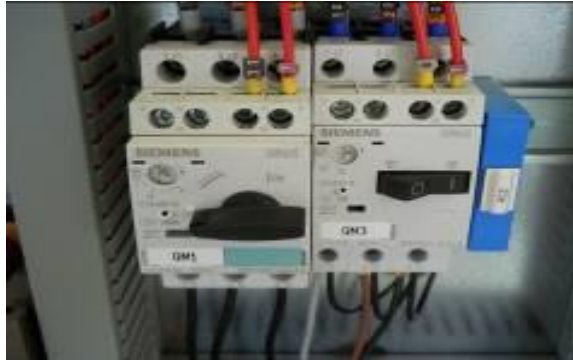
Figura 16 – Interruptor de la bomba en ON
