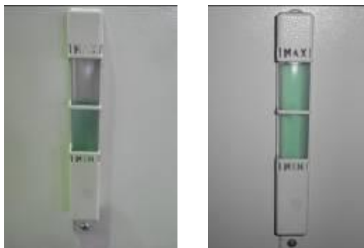
Abbildung 18 / 19 – Füllen des Tanks
