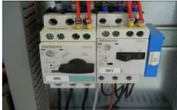
Figura 16 – Interruttore della pompa su ON
