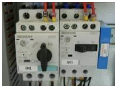
Figura 20 – Interruptores del circuito en ON
