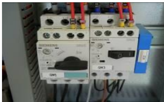
Figure 16 – Interrupteur de la pompe sur ON
