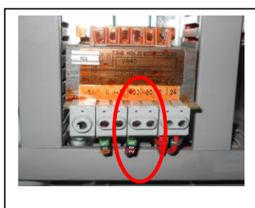
Figura 5 Transformador configurado en 400V
