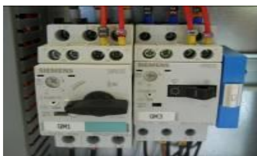
Figura 8 – Interruptores del circuito OFF
