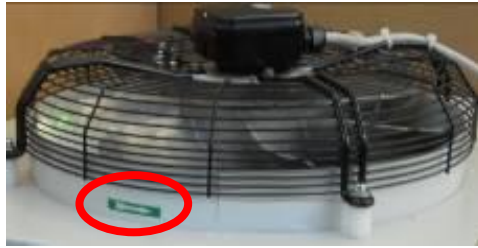
Abbildung 21 – Drehrichtung des Lüfters
