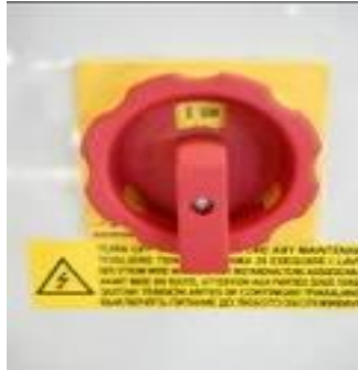
Figure 17 – Interrupteur général sur ON
