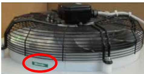
Figura 21 – Dirección de rotación del ventilador
