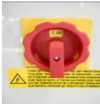
Figura 17 – Interruttore generale su ON
