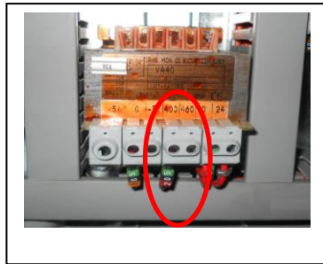
Abbildung 5 Auf 400V eingestellter Transformator
