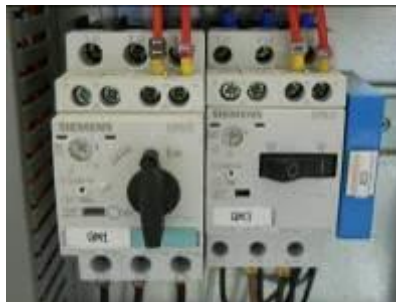
Figura 20 – Tutti gli interruttori di circuito su ON
