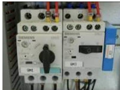
**Abbildung 20 – Alle Trennschalter auf ON**
