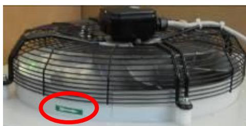
Figura 21 – Direzione di rotazione del ventilatore
