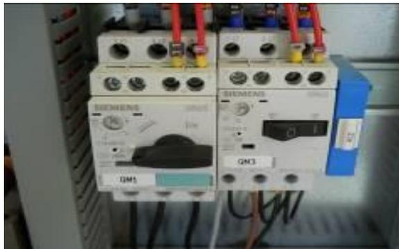
Figura 16 – Interruptor de la bomba en ON
