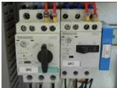
**Figura 20 – Interruptores del circuito en ON**
