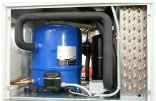
Figura 22 – Posizione del compressore
