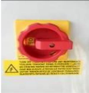
Figure 7 – Interrupteur général OFF
