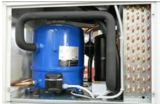
Figura 22 – Posición del compresor
