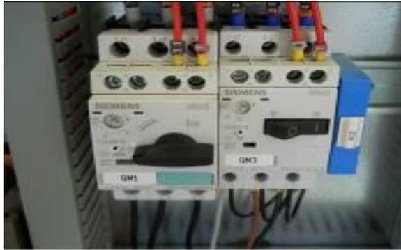
Figure 16 – Interrupteur de la pompe sur ON
